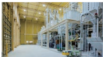
新しくなった種子選穀センター内部
