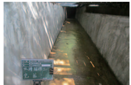
水槽内面補修
