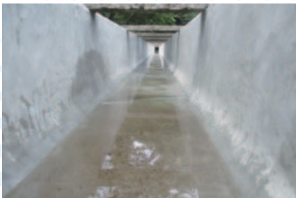
導水路（水路橋）内面補修
