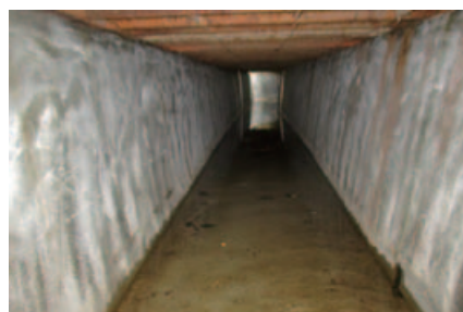
導水路内面補修
