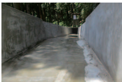
水槽内面補修
