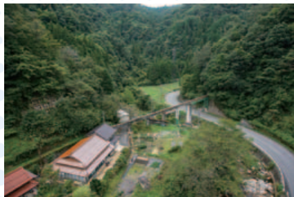
上流より都賀発電所第1水路橋をのぞむ
