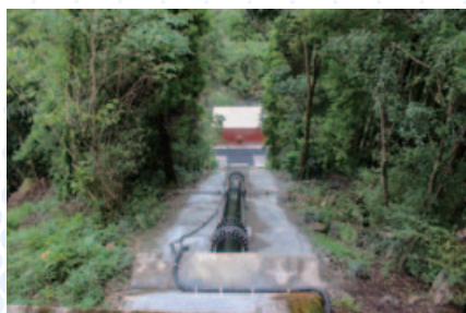
水圧鉄管をヘッドタンクからのぞむ
