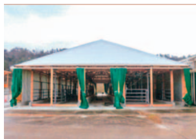
県央地区畜産総合センター
