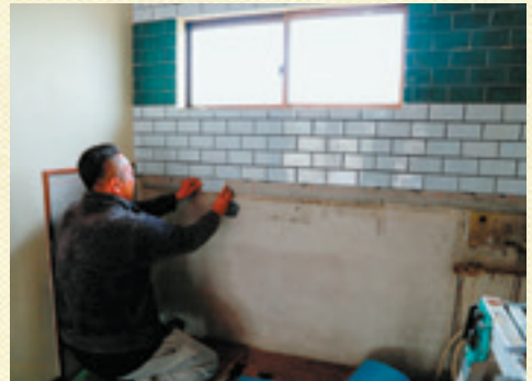
現在、利用者の皆さんの休憩所、キッチン、相談室を兼ねた建物を改修中！空き時間に職員が自らDIYをしています
