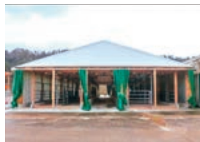
県央地区畜産総合センター
