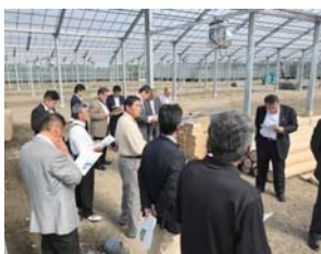
【高度環境制御栽培施設 建設現場視察】
