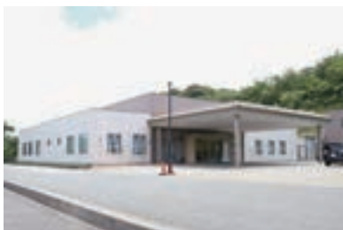
JA江津葬祭会館
