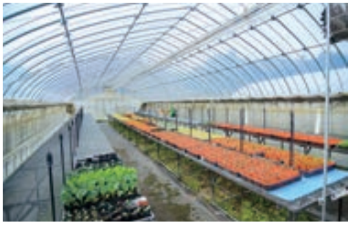
育苗用のハウス施設。自動灌水機も完備されている。
