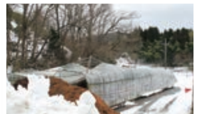
倒壊したビニールハウス
