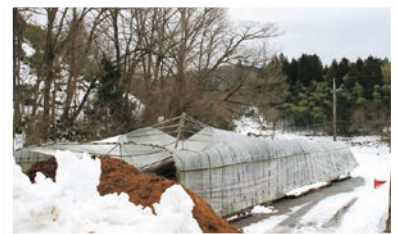
倒壊したビニールハウス
