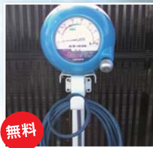
エアタワー2台設置
