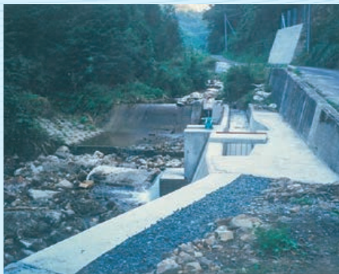
復旧した取水口
