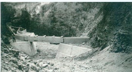
復旧した水路橋
