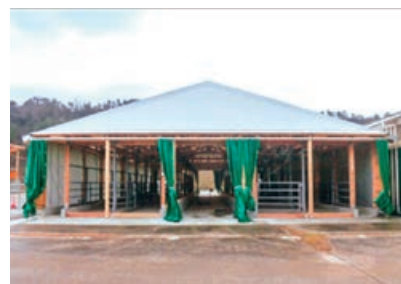
県央地区畜産総合センター
